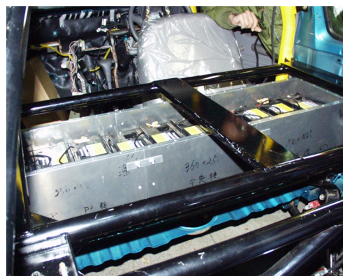
図 5.6: 車体客室内の電池箱
