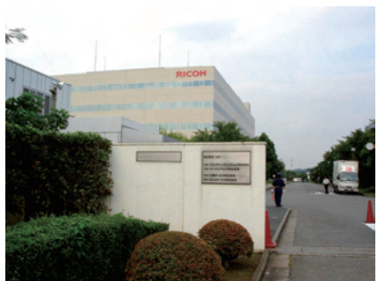
海老名テクノロジーセンター
