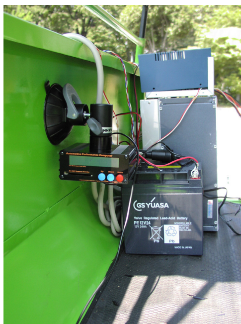
図 7.4 制御用コントローラ外観
